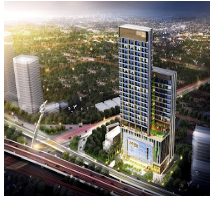
Gambar 1.2 Bangunan gedung bertingkat dengan 2 Tower (Sumber: sohpancoranjakarta.blogspot.com )
