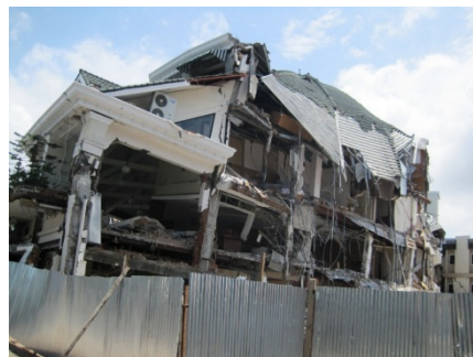
Gambar 1.1 Kerusakan Hotel Ambacang akibat gempa di Padang, Sumatera Barat, Rabu (30/09/2009), (Sumber : wikipedia.org).
