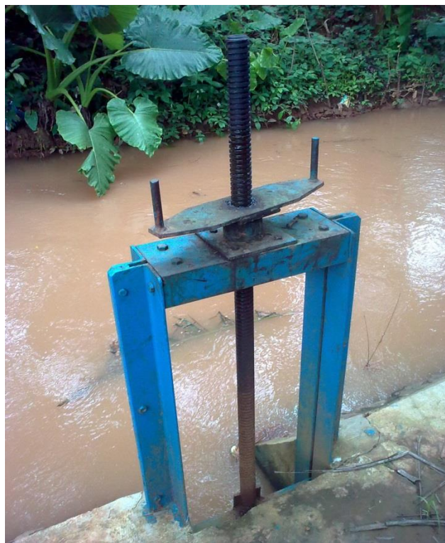
Gambar 1.2 Bangunan Sadap pada Daerah Irigasi Wangundireja
