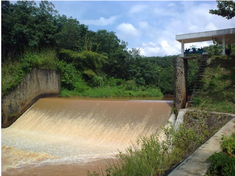
Gambar 1.1 Bendung, Pintu Penguras Bendung dan Pintu Pengambilan ( intake ) pada Daerah Irigasi Wangundireja
