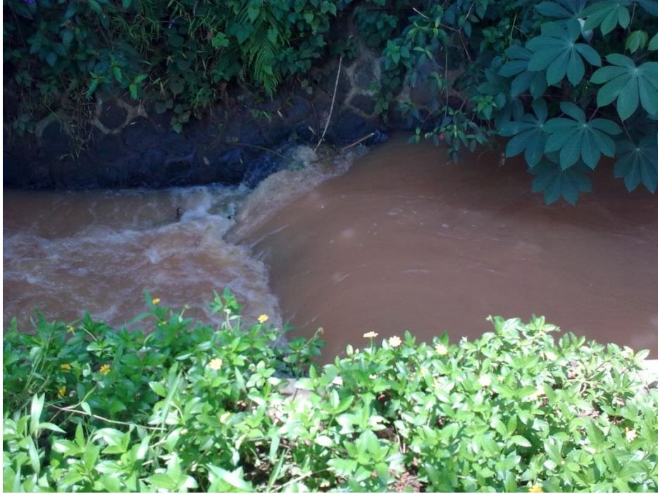
Gambar 1.3 Bangunan Terjun yang termasuk Bangunan Pelengkap pada Daerah Irigasi Wangundireja
