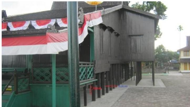
Gambar 1.3. Kolom dan Balok pada Rumah Adat Banjar
