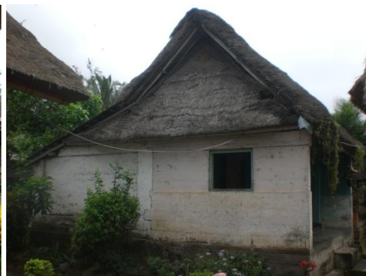
Gambar 3.11 Tampak samping Umah Meten Rumah Sampel No. 32
