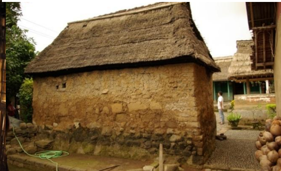
Gambar 4.16 Dinding belakang Paon dimana Paon menghadap frontal ke Bangunan Orangtua Sumber : Dokumentasi Team FSRD
