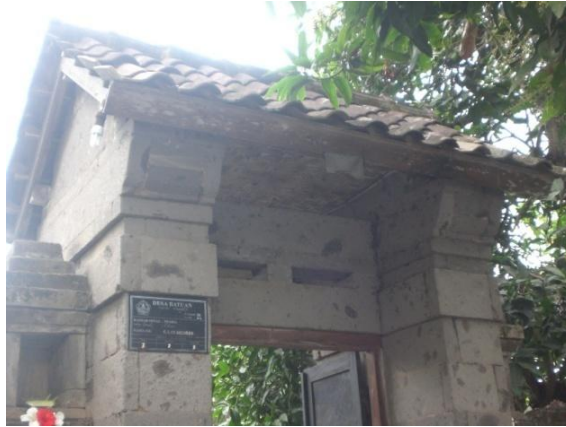
Gambar 3.5 Angkul-angkul pada Rumah Sampel No. 32 Sumber : Dokumentasi Team FSRD
