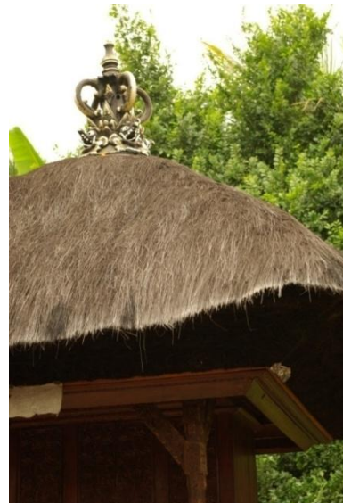
Gambar 4.6 Atap bahan ijuk Pelinggih Sumber : Dokumentasi Team FSRD
