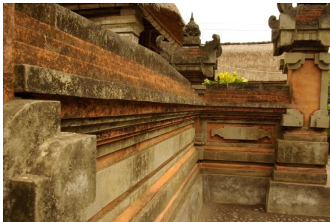
Gambar 4.7 Dinding pemisah area Bangunan Suci dengan bahan bata dan batu paras Sumber : Dokumentasi Team FSRD
