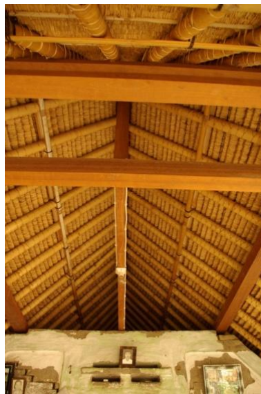
Gambar 4.31 Atap bangunan yang berfungsi sebagai langit-langit Hunian Anak
