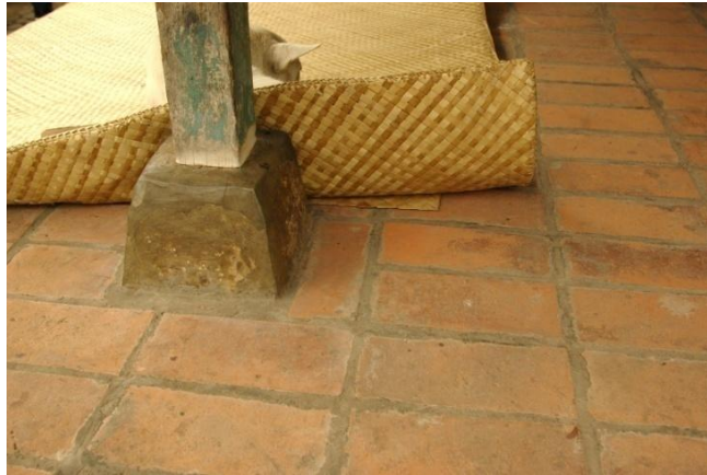
Gambar 4.33 Dudukan tiang pendukung pada Hunian Anak Sumber : Dokumentasi Team FSRD
