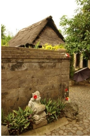
Gambar 4.8 Dinding pemisah area Bangunan Suci dengan bahan batu paras Sumber : Dokumentasi Team FSRD
