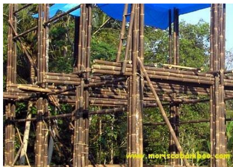
Gambar 1. Sambungan bambu untuk bangunan bertingkat (sumber : www.moriscobamboo.com )
