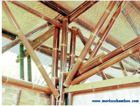
Gambar 2. Sambungan bambu untuk atap (sumber : www.moriscobamboo.com)
