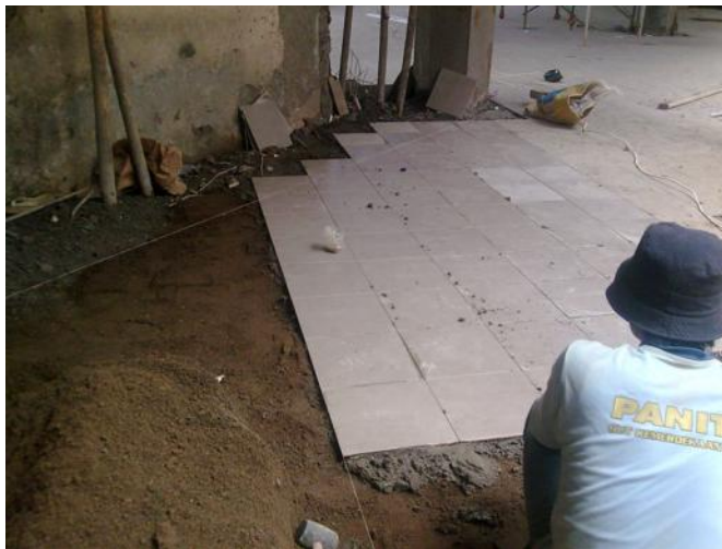
Pekerjaan Penutup Lantai
