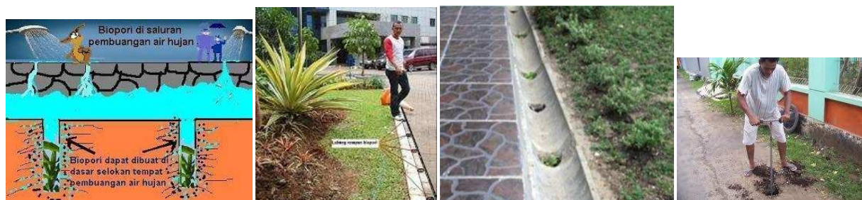
Gambar 2. Biopori pada saluran dan tepi jalan
