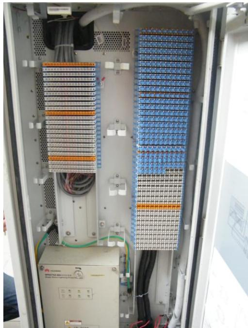
Gambar D-4 Perangkat MSAN untuk Segment Sekunder
