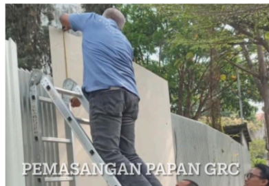
Gambar 3. Pemasangan GRC, Romo Tribowo melakukan pengukuran
