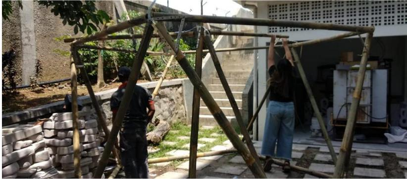
Gambar 10. Proses pemasangan balok
