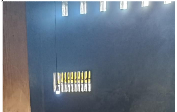
Gambar 2. Kondisi Ventilasi Udara (Sumber: Dok. Pribadi)
