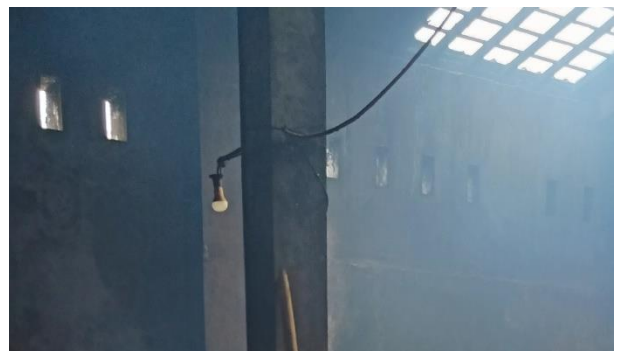
Gambar 3. Kondisi Pencahayaan Atap(Sumber: Dok. Pribadi)
