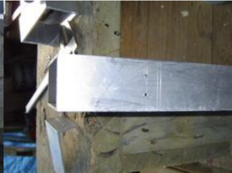
Gambar G.11 Pemasangan Reflektor Atas
