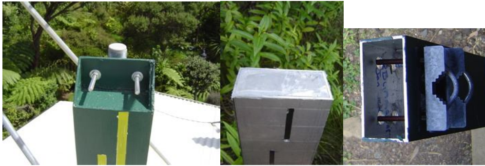
Gambar G.18 Pemasangan Mounting pada Tiang Penyangga
