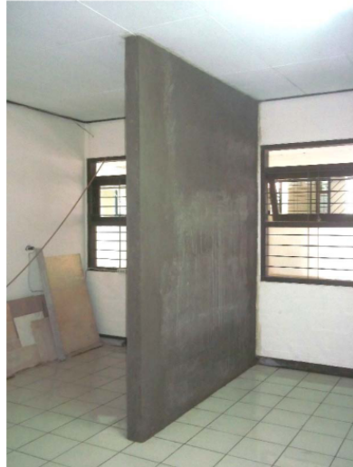
Gambar 5 Dinding Mortar Cor Ditempat Ukuran Sebenarnya
