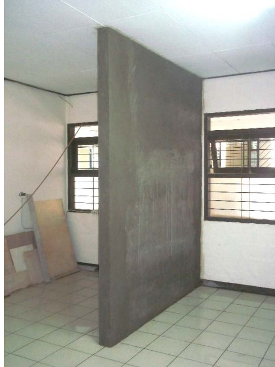
Gambar 5 Dinding Mortar Cor Ditempat Ukuran Sebenarnya
