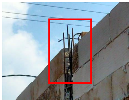
Gambar 31. Kesalahan Detailing antar Kolom dengan Balok
