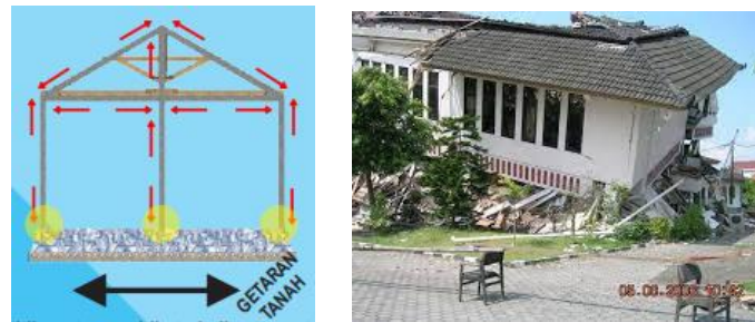
Gambar 13. Kerusakan akibat Kesalahan Detailing Sloof Sumber: Google Photos, 2023
