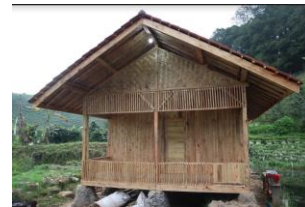
Tampak Depan Bangunan
