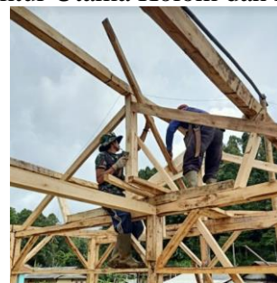
Gambar 7. Tahapan Pemasangan Konstruksi Atap
