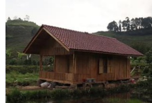
Tampak Samping Bangunan
