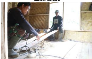
Gambar 13. Tahapan Pemasangan Meja Dapur
