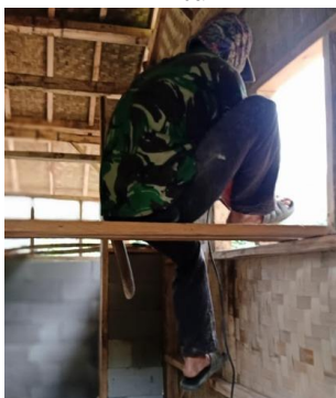
Gambar 11. Tahapan Lanjutan Pemasangan Dinding
