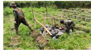
Gambar 3. Tahapan Persiapan Pembuatan Pondasi
