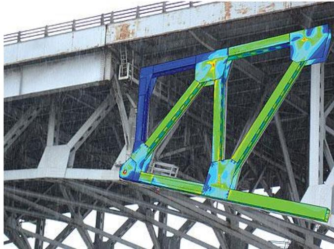
Gambar 1.10 Simulasi numerik struktur jembatan rangka dengan ABAQUS [3].
