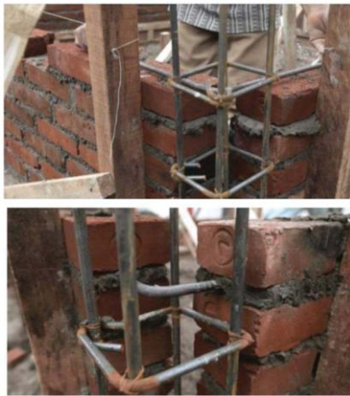
Gambar 8. Pemasangan angkur pada dinding bata untuk memperkuat dinding terhadap beban gempa
