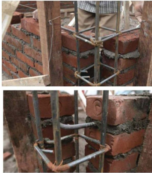
Gambar 9. Pemasangan angkur pada dinding bata untuk memperkuat dinding terhadap beban gempa
