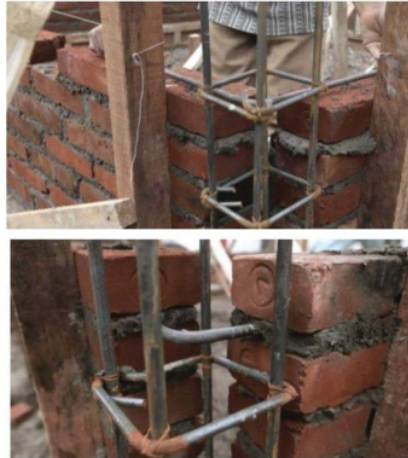
Gambar 9. Pemasangan angkur pada dinding bata untuk memperkuat dinding terhadap beban gempa
