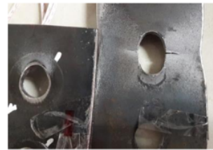
b. Kerusakan Lubang Baut
