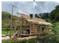
Gambar 8. Tahapan Pemasangan Genteng
