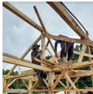
Gambar 7. Tahapan Pemasangan Konstruksi Atap
