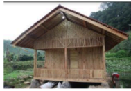
Tampak Depan Bangunan
