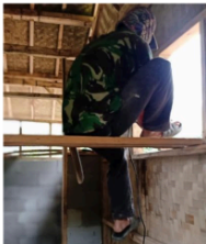
Gambar 11. Tahapan Lanjutan Pemasangan Dinding
