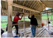
Gambar 10. Tahapan Pemasangan Jendela dan Pintu
