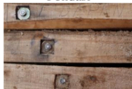
Gambar 4. Tahapan Persiapan Perakitan Kolom dan Balok Kayu Laminasi
