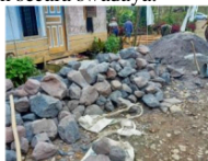
Gambar 2. Tahapan Awal Persiapan Pengadaan Material
