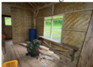
Gambar 12 Tahapan Pemasangan Instalasi Listrik
