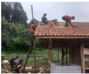
Gambar 9. Tahapan Pemasangan Dinding
