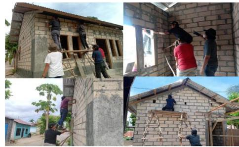
**Gambar 9.** Pengerjaan perkuatan metode ferosemen yang dilakukan oleh Asisten TFL atau peserta MSIB Kampus Merdeka Angkatan
