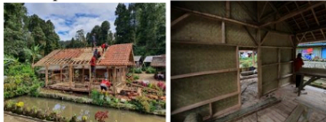
Gambar 14. Pekerjaan Pemasangan Genteng, Pemasangan, Dinding Tahap 2, Kusen Pintu Dan Jendela, dan Pemasangan Lantai
