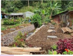
Gambar 9. Pekerjaan Dudukan Pondasi
