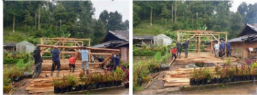
Gambar 11. Pekerjaan Perakitan Kolom dan Portal
