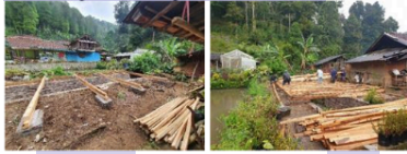
Gambar 10. Pekerjaan Perakitan Balok
