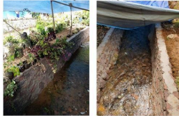
Gambar 8. Pekerjaan Dinding Penahan Tanah
