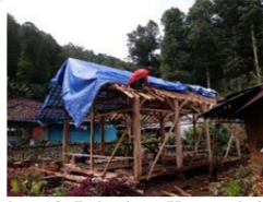
Gambar 12. Pekerjaan Konstruksi Atap
