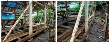
Gambar 13. Pekerjaan Pemasangan Reng, Pemasangan Lantai dan Pemasangan Dinding
