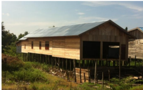
Gambar 1. Gudang dan rumah kayu tipe panggung (dokumentasi pribadi).
