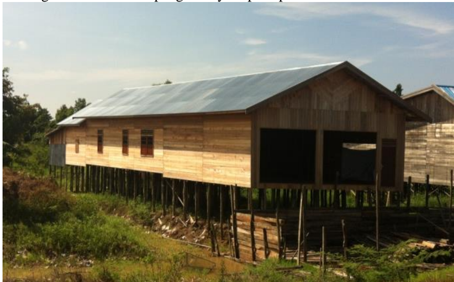
Gambar 1. Gudang dan rumah kayu tipe panggung.
