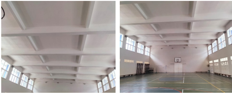
Gambar 3 Foto Konstruksi Prestress di BPK Jl. Jend. Sudirman 638 Bandung Sumber: Dokumentasi Tokoh
