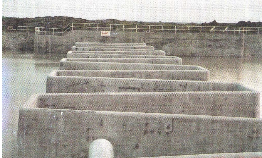
Gambar 1.2 Bendung gergaji Ciwadas, Jawa Barat [Pusat Penelitian dan Pengembangan Pengairan]
