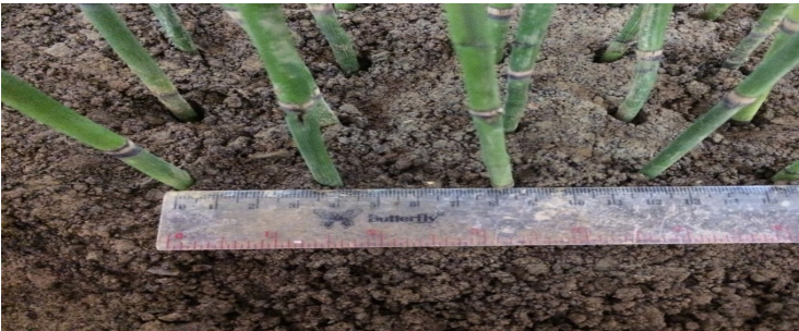
Gambar L.1.5 Mengukur dan Memastikan Jarak Antar Vegetasi Sudah Sesuai dengan Rencana
