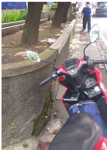
Gambar 2 Trotoar dan Tepi Jalan digunakan Parkir Motor
