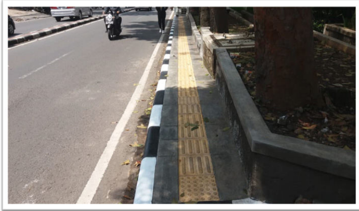
Gambar 8 Trotoar yang telah diperbaiki
