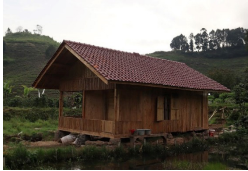
Gambar 6 Tampak Samping Bangunan
