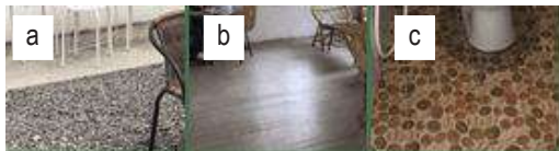
Gambar 12. Material Lantai Concrete dan Batu Kerikil (A), Parket Kayu (B), Keramik (C) Sumber: Dokumentasi Penulis, 2022
