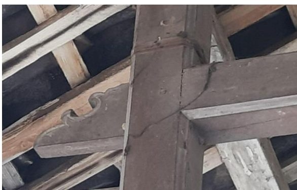
Gambar 8. Tou Kung dengan Elemen Estetis Sederhana di Teras Rumah Peranakan, Jamblang
