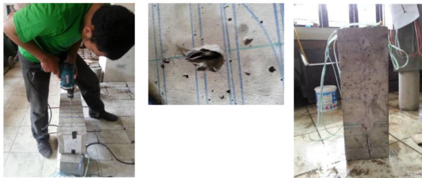
Gambar 4. Proses pemasangan pen-binder
