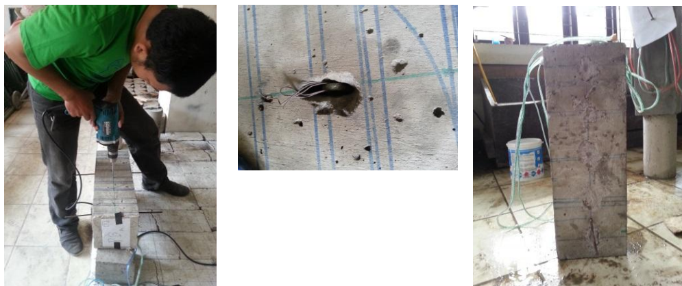
Gambar 4. Proses pemasangan pen-binder
