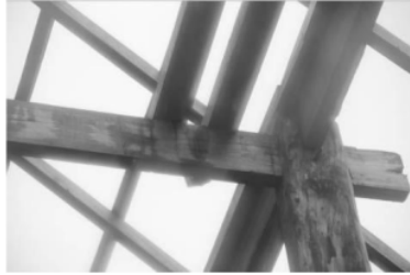
Gambar 1. Sambungan join balok-atap dengan tiang (kolom) pada Rumah Kayu Minangkabau. Sumber: dokumentasi pribadi.
