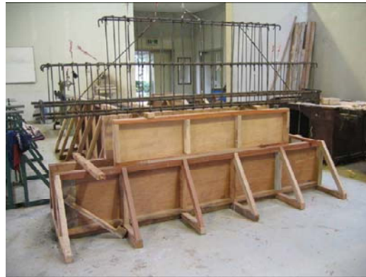
Gambar L2.1 Bekisting dan tulangan balok yang telah dirakit
