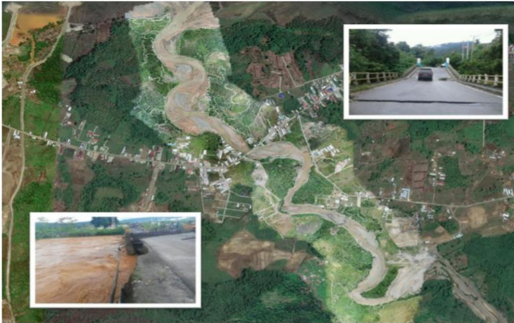
Gambar 2-10 Lokasi Jembatan Bahodopi (sumber: Moerwanto, A.S dan Zulfan, J. 2020)
