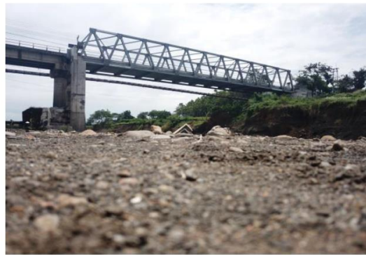
Gambar 7-5 Kondisi Jembatan Cipamingkis Setelah Perbaikan (Pusjatan 2018) (sumber: Setiati, N. R dan Kurniawati, E. 2021)
