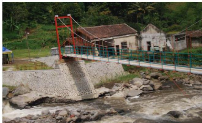
Gambar 0.1 Dasar Fondasi Jembatan Gantung Mulai Tergerus oleh Aliran Sungai ( sumber: Nenny. 2016 )
