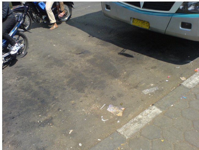
Gambar Kondisi Perkerasan Bergelombang
