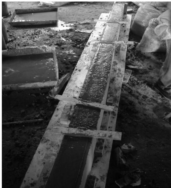
Gambar L5.9 Balok Telah Dicetak
