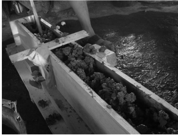
Gambar L5.8 Adonan Beton Dicetak Dalam Bekisting
