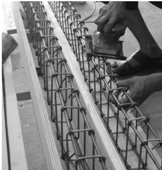
Gambar L5.2 Permukaan Tulangan Diampelas Untuk Menempatkan Strain Gauge
