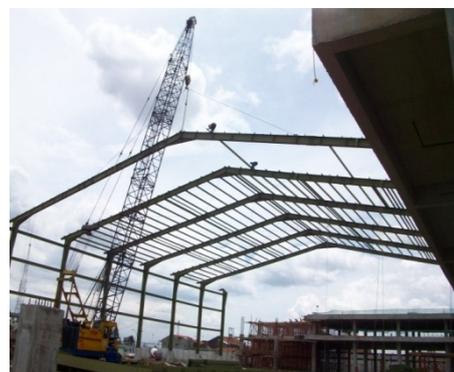
**Gambar 1.2 Rangka Atap Menggunakan Baja IWF**
