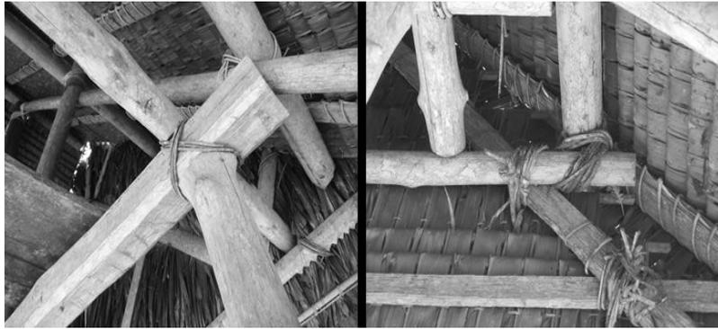
Gambar 2 Sambungan konstruksi Uma dengan sistem pasak dan ikatan
