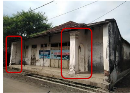
Gambar 5. Pengaruh Budaya Eropa pada Kolom Penyangga di Teras Rumah Peranakan, Jamblang
