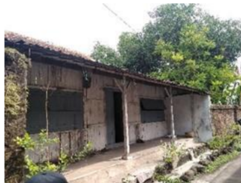
Gambar 3. Teras di Rumah Peranakan Jamblang
