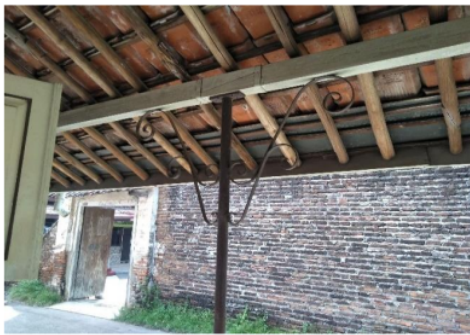
Gambar 4. Pintu Samping di Teras (atas) dan Motif Sulur pada Tiang Penyangga di Teras Rumah Peranakan, Jamblang (bawah)
