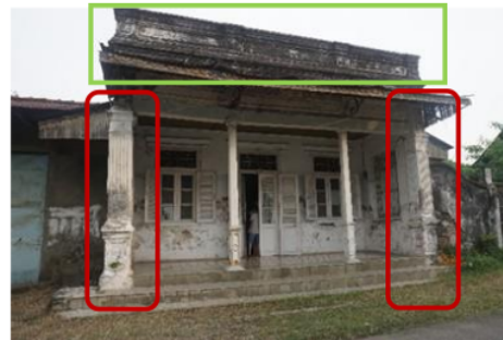
Gambar 6. Pengaruh Budaya Eropa pada Kolom Penyangga di Teras (merah) & Entablature pada atap rumah Peranakan, Jamblang (hijau)
