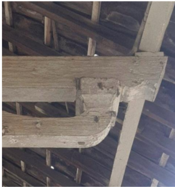
Gambar 7. Dou Gong pada Rumah Peranakan di Jamblang, Cirebon
