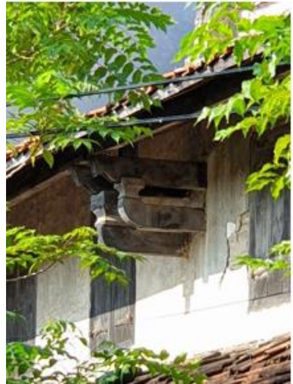
Gambar 13. Konstruksi Tou Kung Penyangga Teritisan Lantai 2
