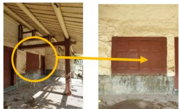
Gambar 14. Aplikasi Warna Merah pada Kolom, Kuda-kuda, Pintu dan Jendela
