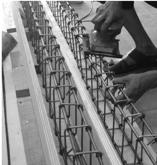
Gambar L5.2 Permukaan Tulangan Diampelas Untuk Menempatkan Strain Gauge
