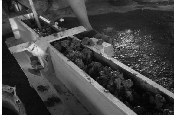
Gambar L5.8 Adonan Beton Dicetak Dalam Bekisting
