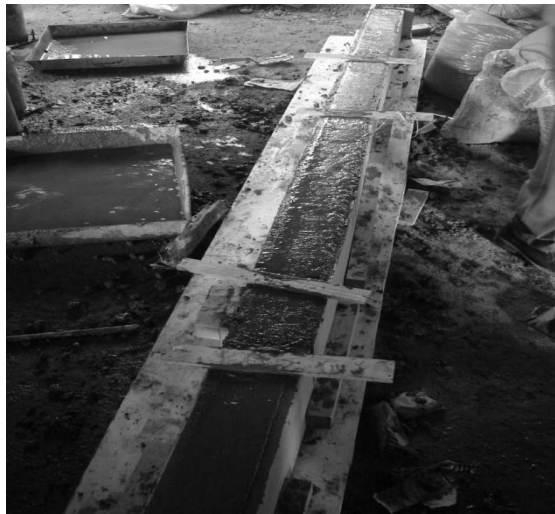
Gambar L5.9 Balok Telah Dicetak
