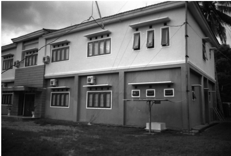
Bangunan Kantor Kehutanan Manusela Masohi yang menggunakan batu api sebagai campuran beton
