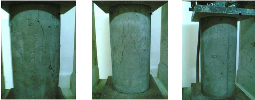
Gambar kerusakan sampel beton dengan batu api 50% umur 28 hari
