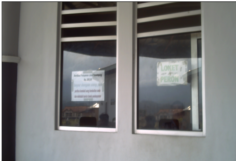
Loket/ Peron Pada Pintu Masuk Penumpang
