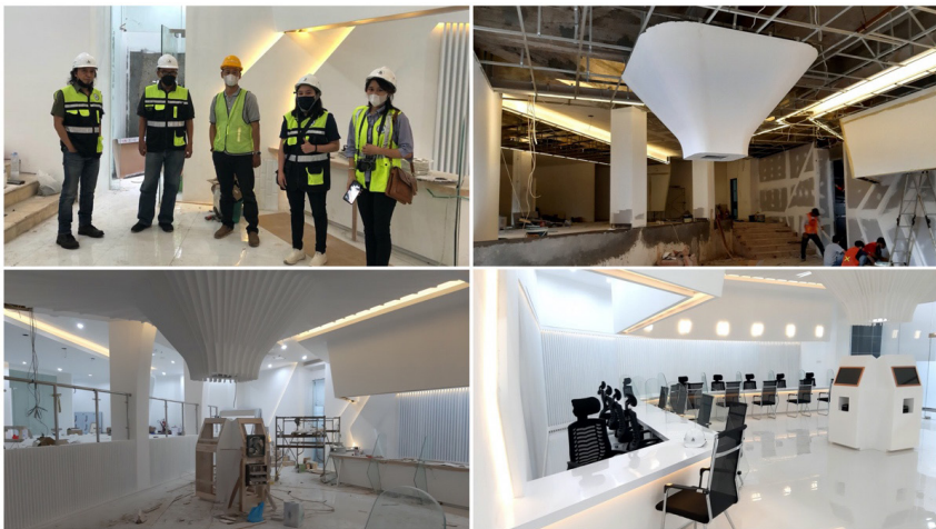
Gambar 2 Riri dan team di proyek Pengawasan Pembangunan Ruang One Stop Service di Gedung Sate
