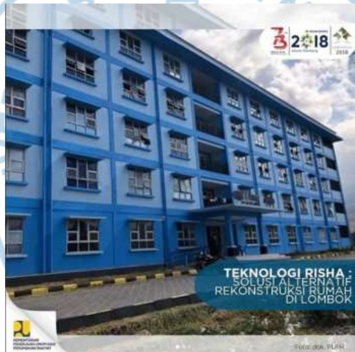
Gambar 1.1 Rumah Susun yang Memanfaatkan Teknologi RISHA di Lombok
