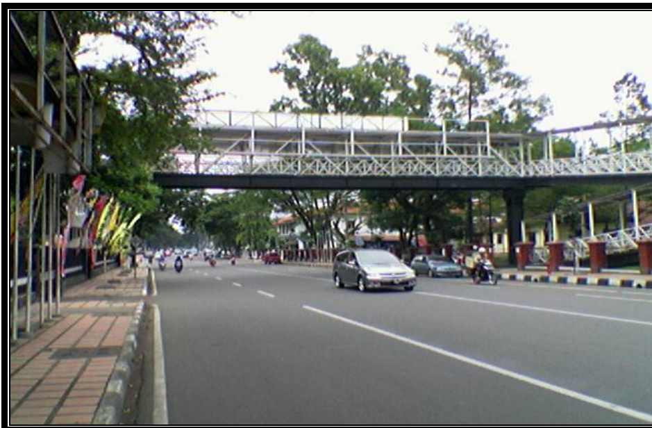
Jembatan Penyeberangan Tampak Barat
