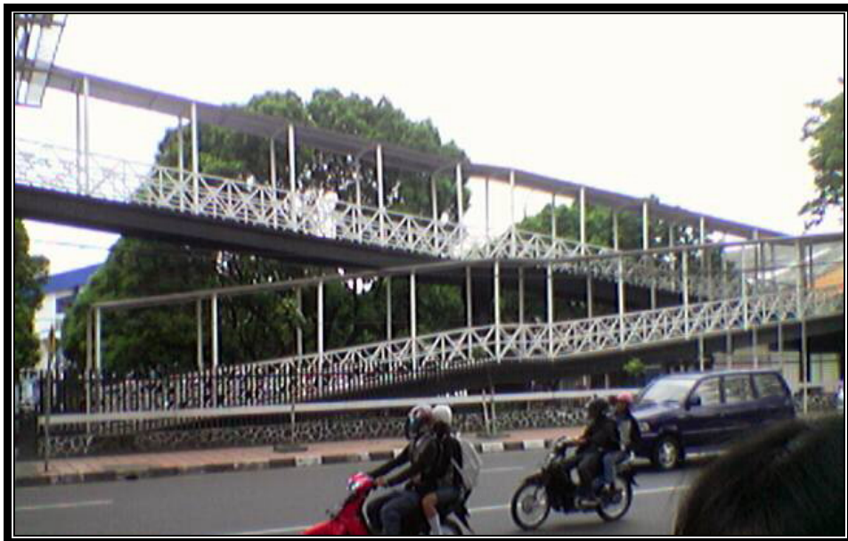
Ramp Naik/Turun Tampak Utara
