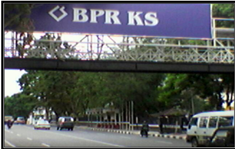
Jembatan Penyeberangan Tampak Timur
