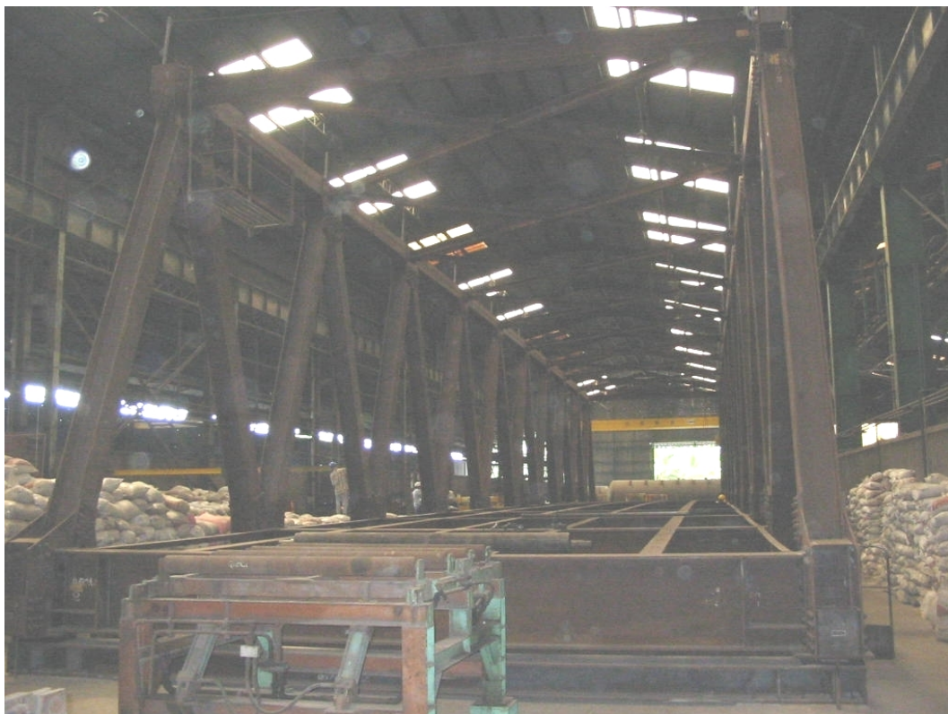
Tampak depan jembatan
