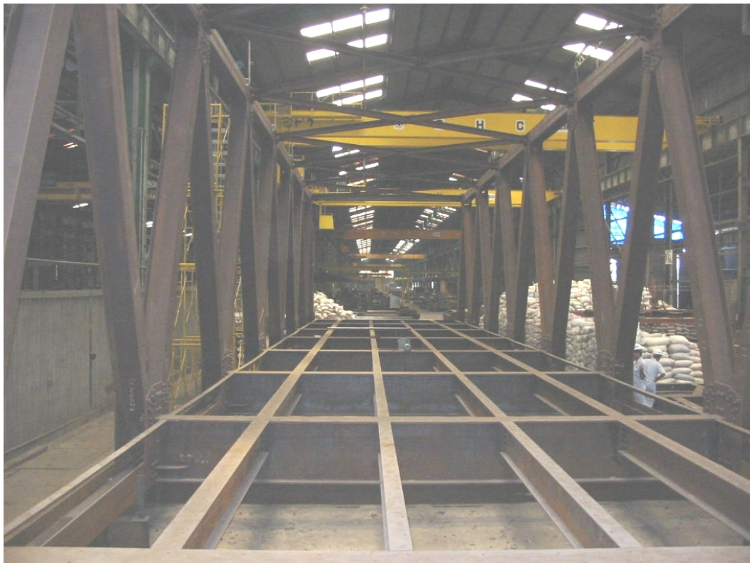
Bagian dalam jembatan
